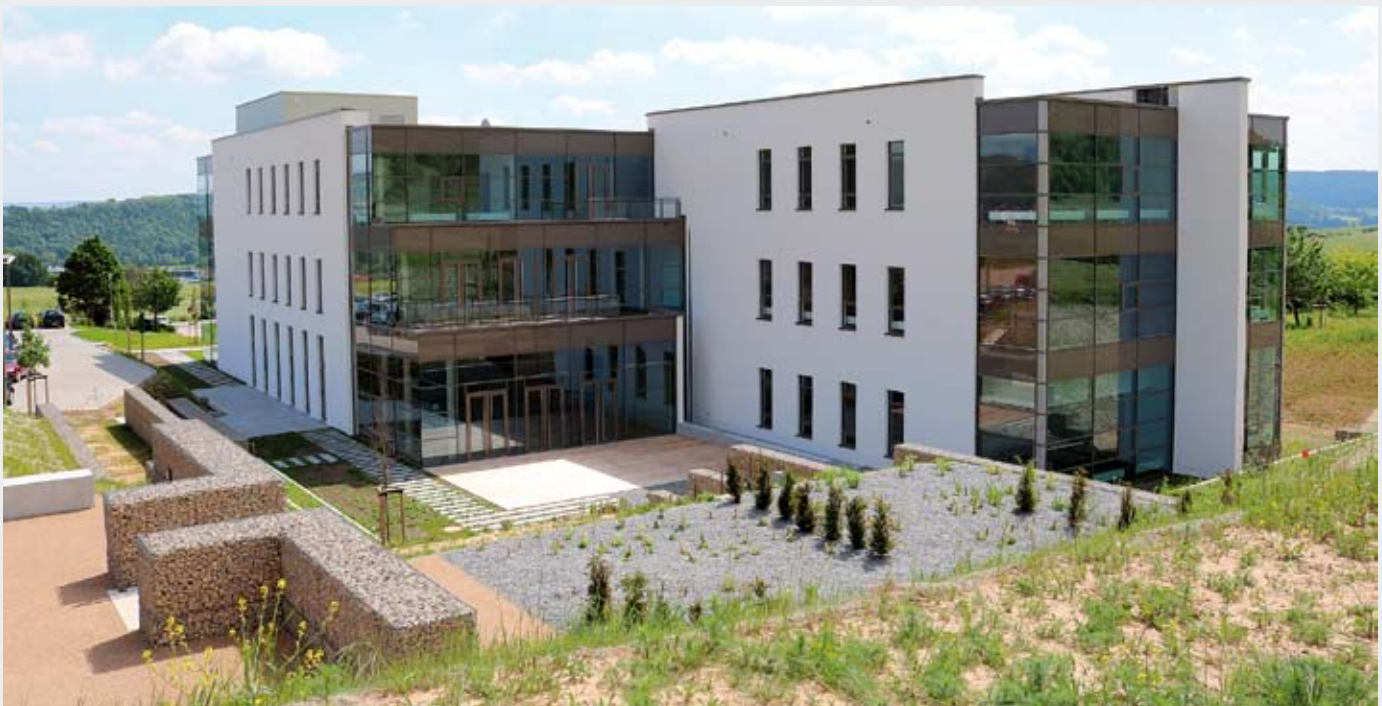
Neue Aufgaben erfordern neue Räume. Der Erweiterungsbau der Landesärztekammer ist seit dem Frühsommer 2017 fertiggestellt.
